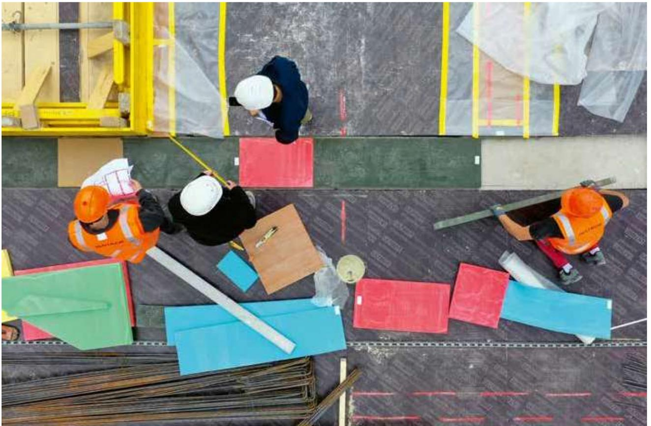
Mise en place des élastomères sur les murs du sous-sol, avant le bétonnage de la dalle du rez. Les différentes couleurs correspondent au plan de calepinage. (HELDER CARDOSO/PILLET)
