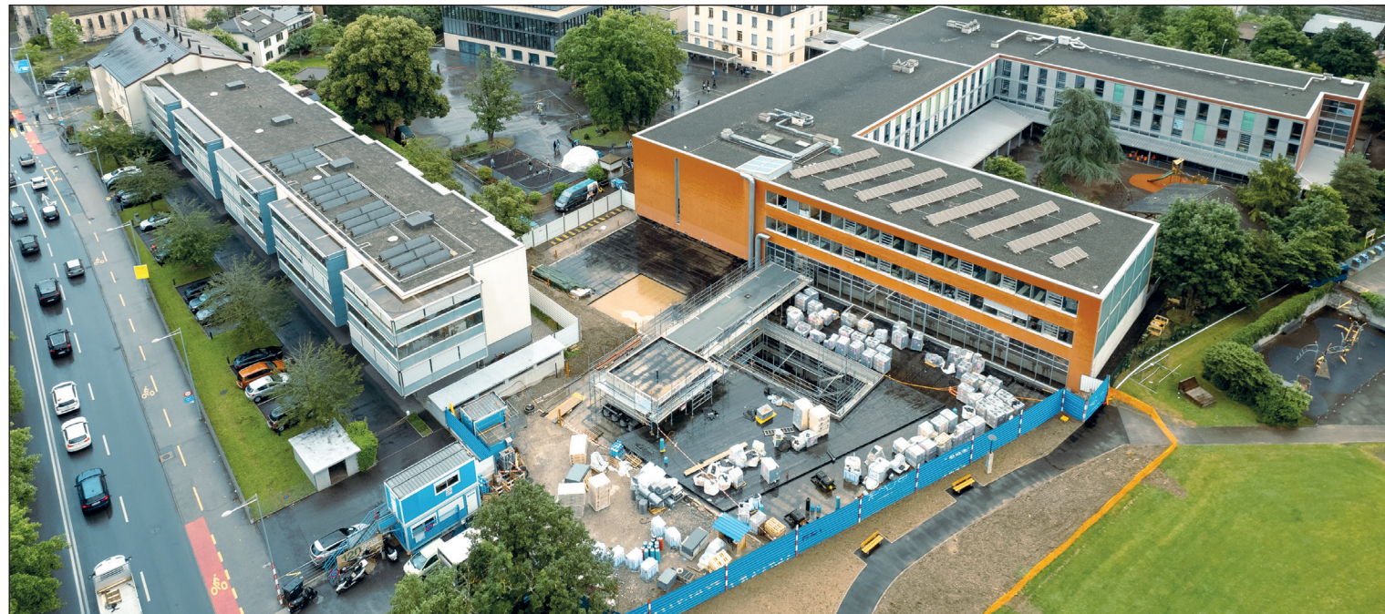
Après avoir dirigé les chantiers des bâtiments B10 et B17, Pillet SA s'engage à nouveau avec le B25, auprès de l'IIL.
